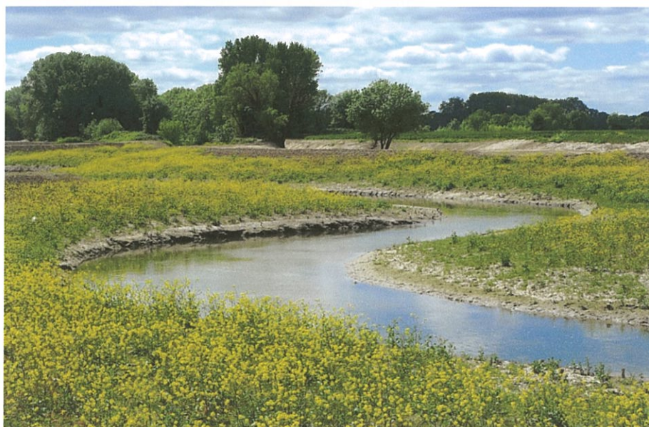
Aspect du cours d'eau reméandré au printemps suivant les travaux de terrassement. Source : EPTB Vistre. Date : avril 2016.
